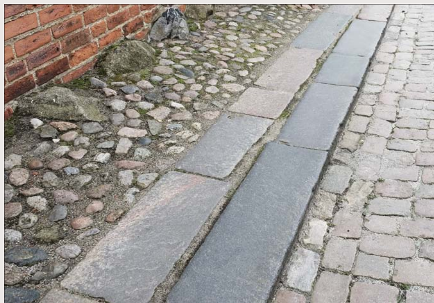
Eksisterende granitbelægning i Korsbrødregade Belægningen genanvendes, men lægges påny
