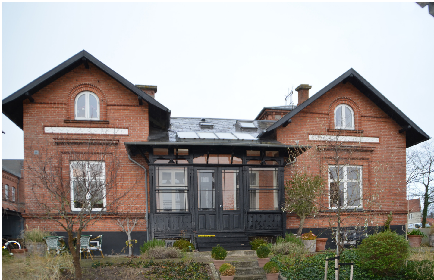
Havesiden af Kongens Bastionsvej 3 opført omkring 1890.
