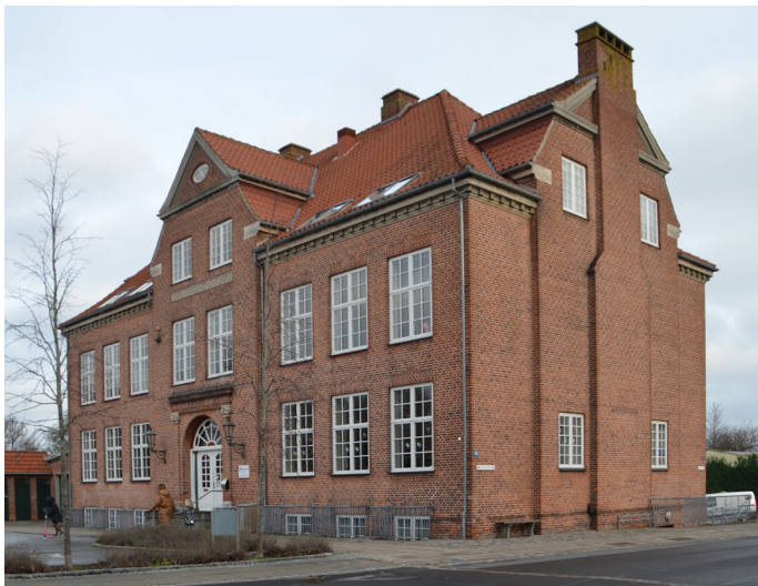
Nørrevoldgade 9, skolebygning opført 1916-17 for Nyborg Kommune. Formsprog: Nationalromantik/nybarok/nyklassicisme.
