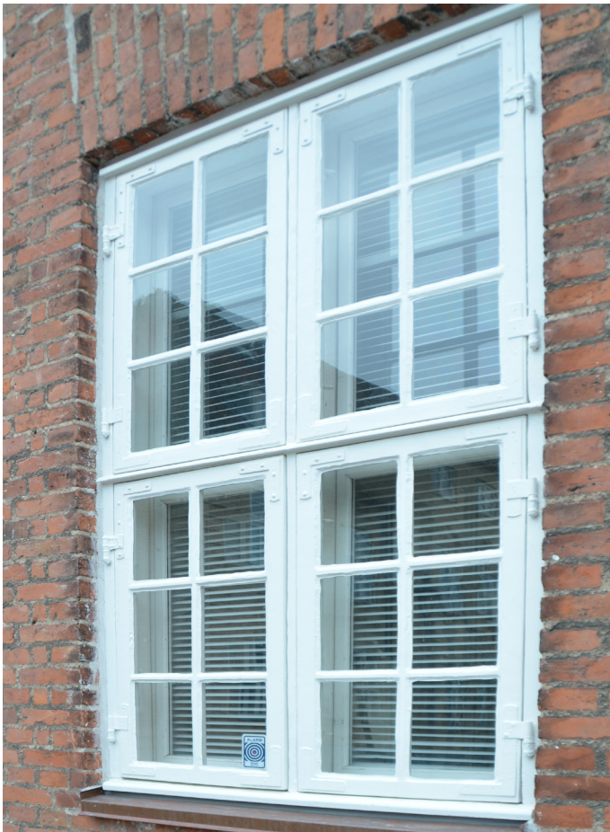
Originalt vindue med sprosser og ruder af et lag glas isat i kitfals energiforbedret med indvendige forsatsrammer.
