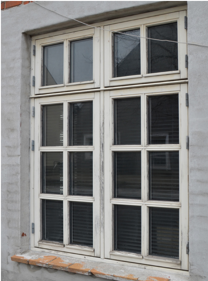
Nyere småsproset vindue med 16 små termoruder isat med glaslister.
