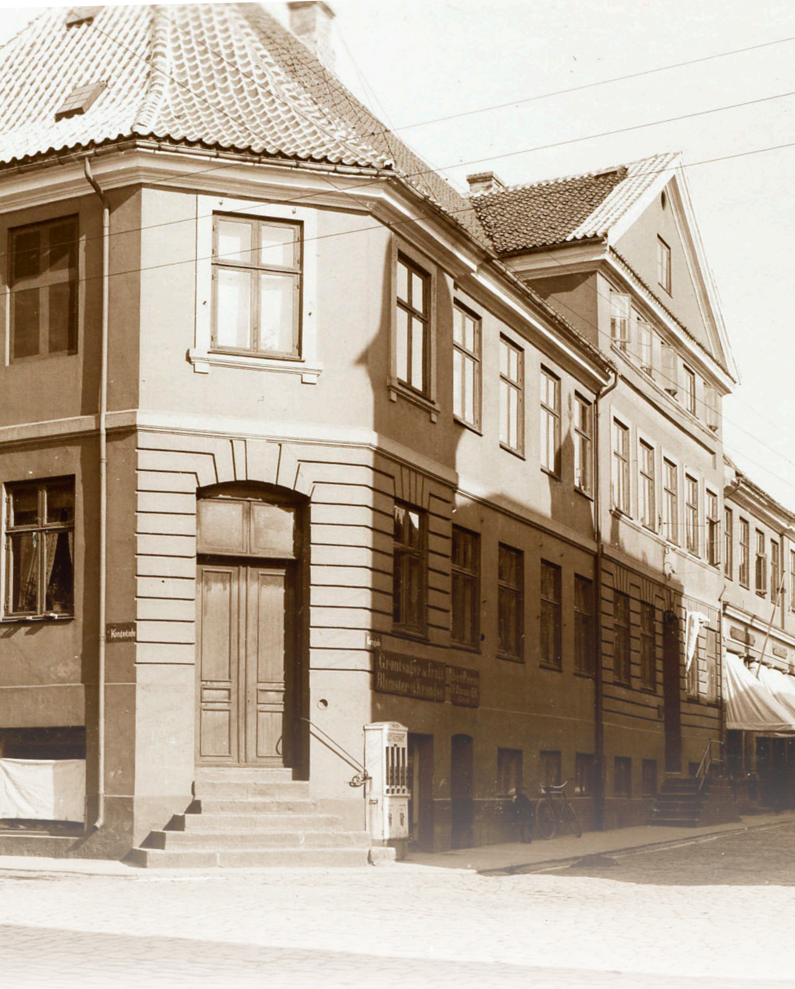
Korsgade 4 i 1914. Billedet illustrerer tydeligt, hvorfor det var nødvendigt med et svaj i tegltagene. Uden svaj var taggesimsen blevet rykket ned til overkanten af vinduerne, hvilket ville være helt uacceptabelt for en klassicistisk facadekomposition. Ud fra tilsvarende hensyn til facadekompositionen er taget på gavlkvisten uden svaj. Her handler det om, at gavlkvisten afsluttes med en præcis trekant uden svaj.
