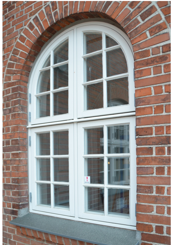
Nyt vindue med koblede rammer, hvor yderste rammer har ruder af enkelt lag glas isat i kitfals ligesom de oprindelige, originale vinduer. Energiforbedringen er her foretaget med rammer koblet på indersiden af de udvendige rammer.
