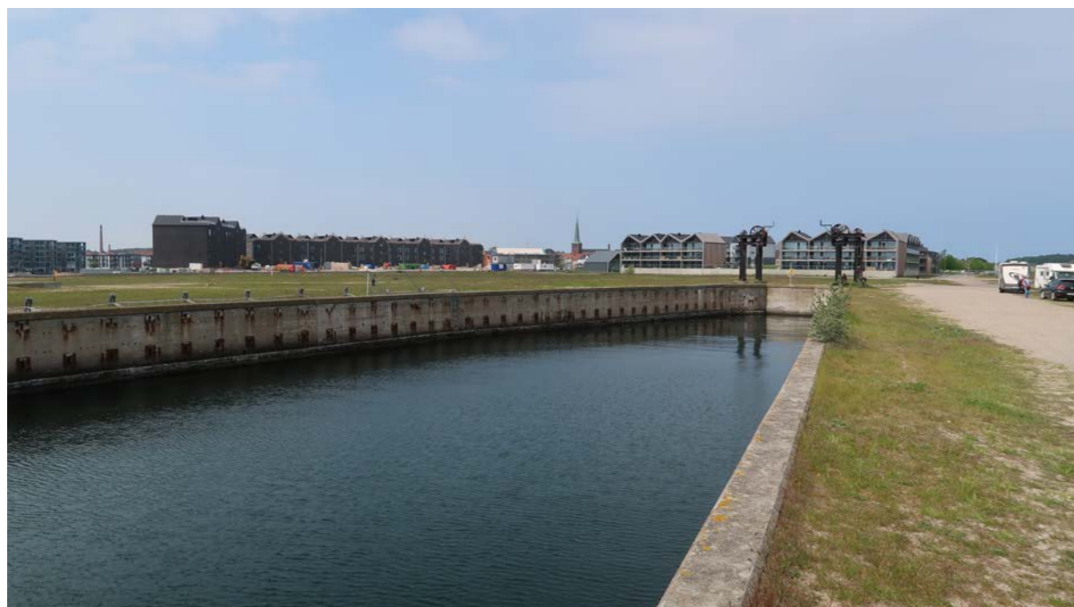
Jernbane-færgelejerne med det bevarede rampeanlæg. Foto Peter Holm 2019
