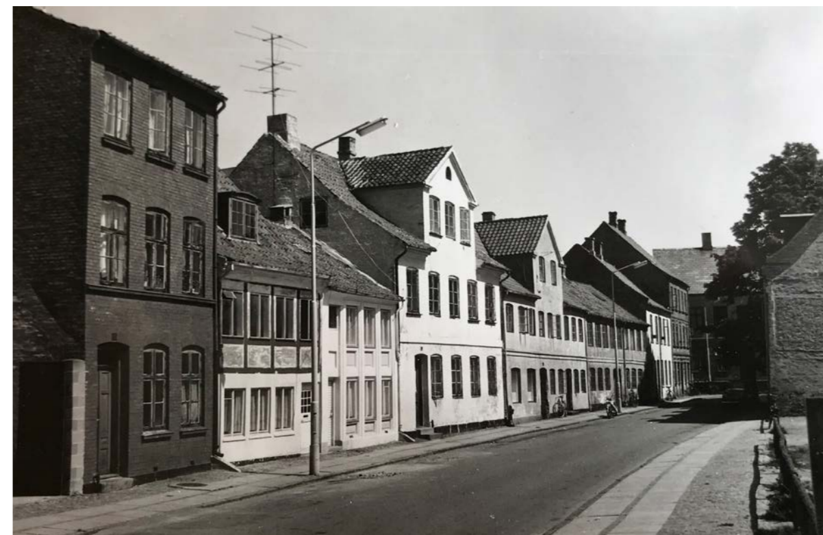
Nyenstad før sanering. Foto Peter Dragsbo 1968
